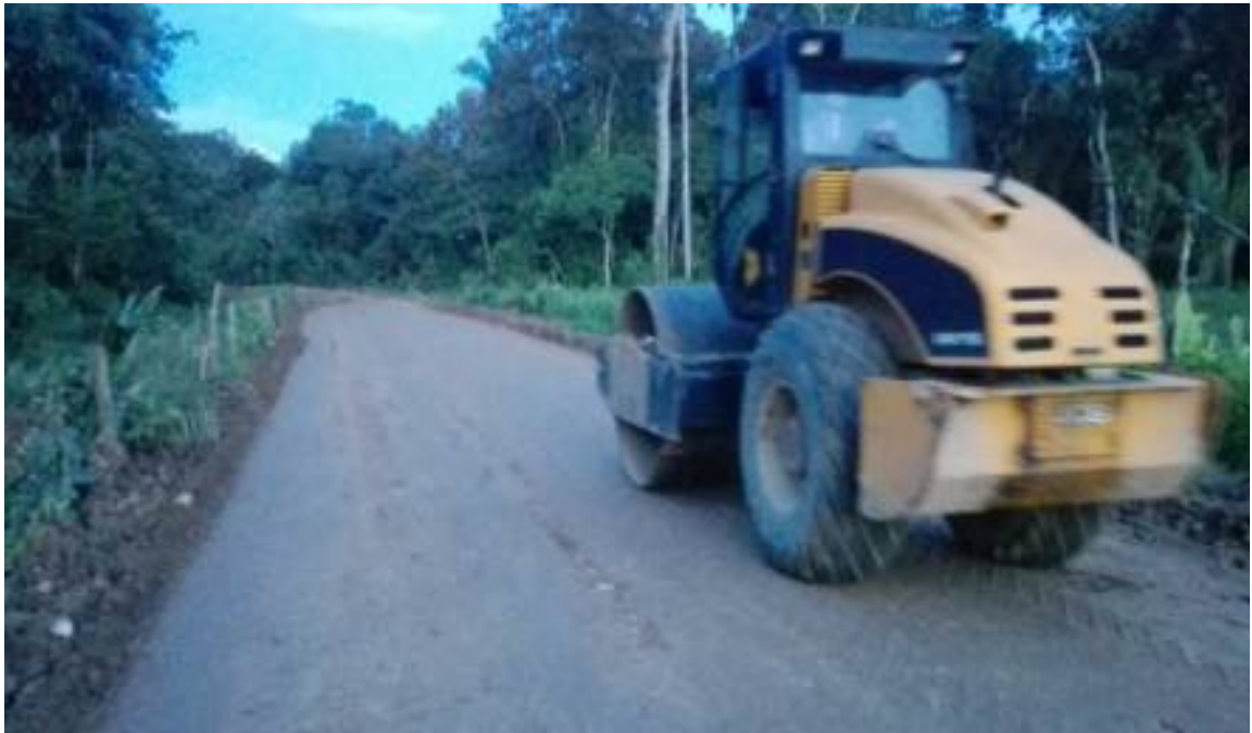
FOTO No 17 PROCESO DE COMPACTACIÓN FINAL.
