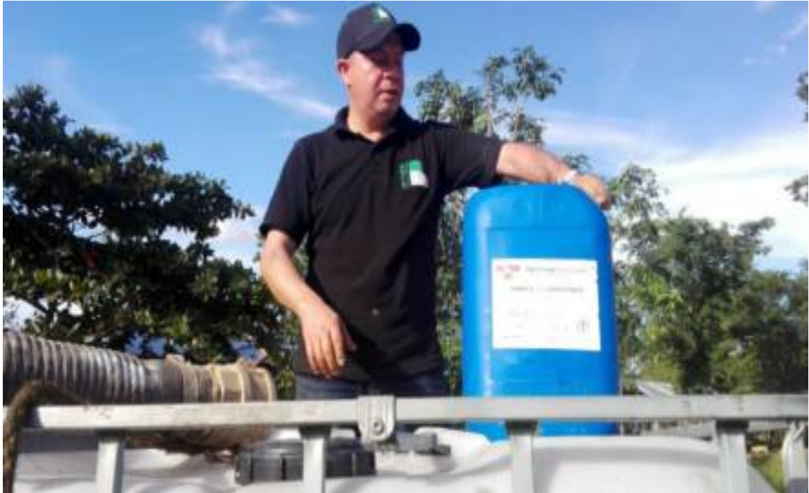
FOTO N° 11 PRODUCTO TERRA-3000 LISTO A SER INCORPORADO CON EL VOLUMEN DE AGUA PREVIAMENTE CALCULADO PARA OBTENER LA COMPACTACIÓN ÓPTIMA.
