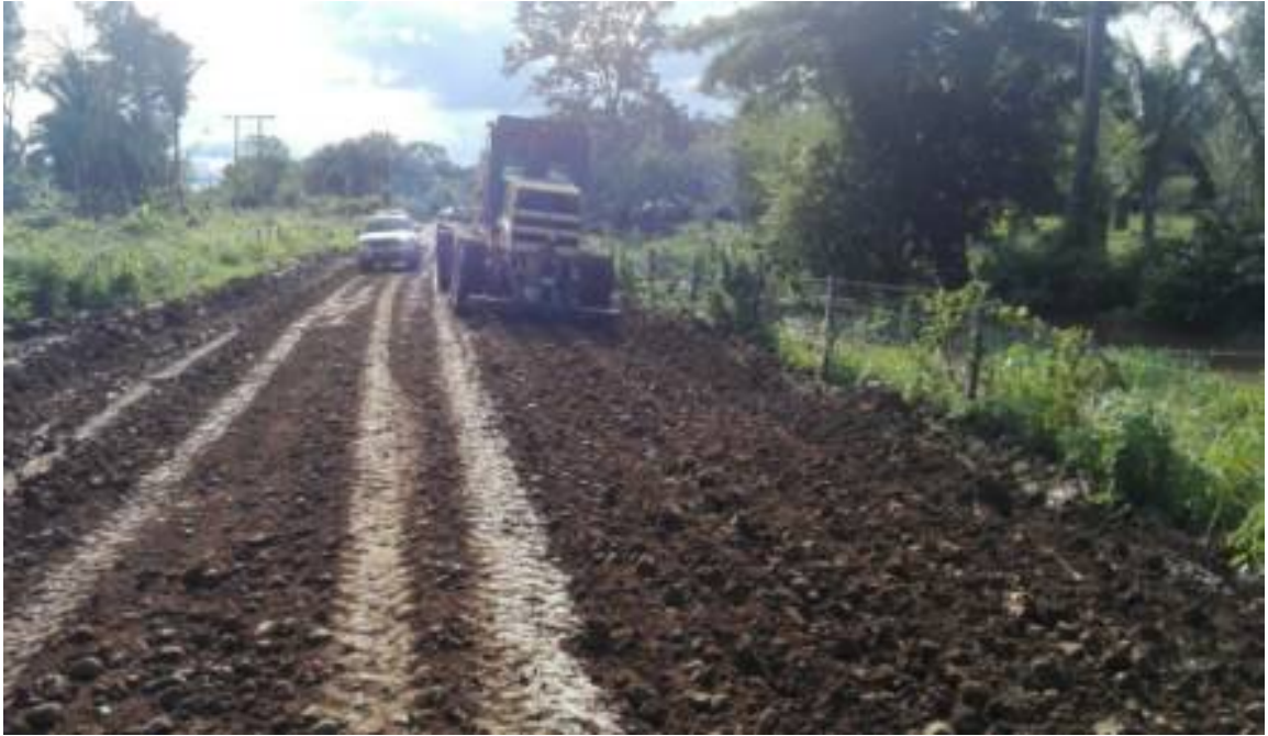
FOTO No 13 SE APRECIA PROCESO MEZCLADO PARA HOMOGENIZACIÓN
