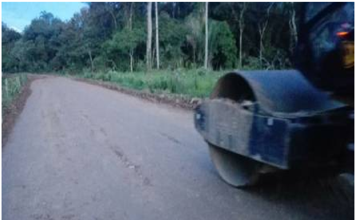
FOTO No 18 PROCESO DE COMPACTACIÓN FINAL.
