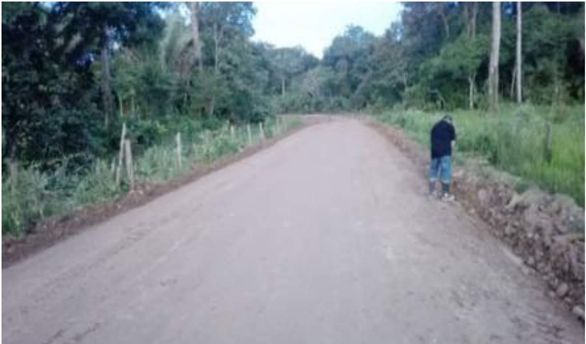
FOTO No 19 ESTADO FINAL DE LA VÍA.
