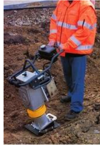
Verfülle und verdichte mit der TERRA-3000®-Bodenmaterial-Mischung
