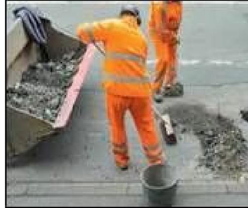
Entferne die Über- und Rückstände von **TERRA-Schlagloch-Fix**, verdichte und bring Bitumen oder Asphalt als Deckschicht hinzu.
