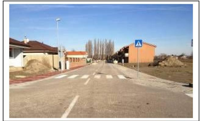
Da die behandelte Schicht eine sehr gute Tragfähigkeit hat, kann die Verschleißschicht wesentlich dünner und damit günstiger gehalten werden, wodurch massive Einsparungen resultieren.
